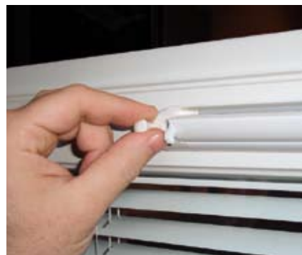
Kesä-talviasento voidaan vaihtaa huone-tilasta venttiilin ohjausvivusta...
