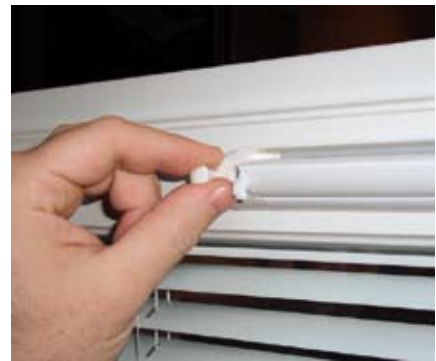
Kesä-talviasento voidaan vaihtaa huone-tilasta venttiilin ohjausvivusta...
