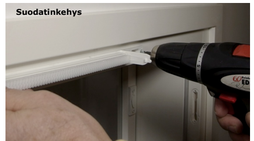
Venttiiliyksikkö on pikakiinnitteinen
